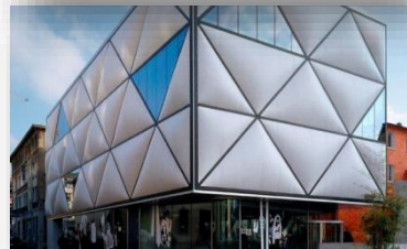
صور رقم 7،8،9 استخدام وسادات ETFE فى الواجهات الخارجية (مرجع 23)
